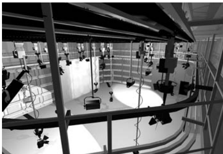
3D-Ansicht einer Studioplanung mit Teleskopleuchtenhängern
